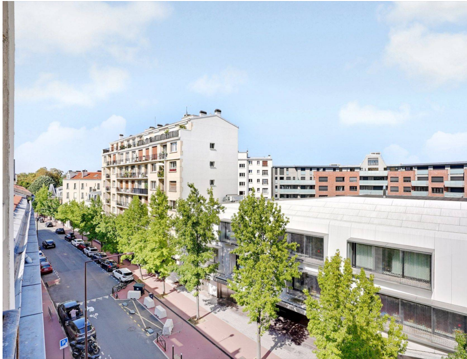
Appartement,f2,Charenton Le Pont,94220,Val de Marne.
